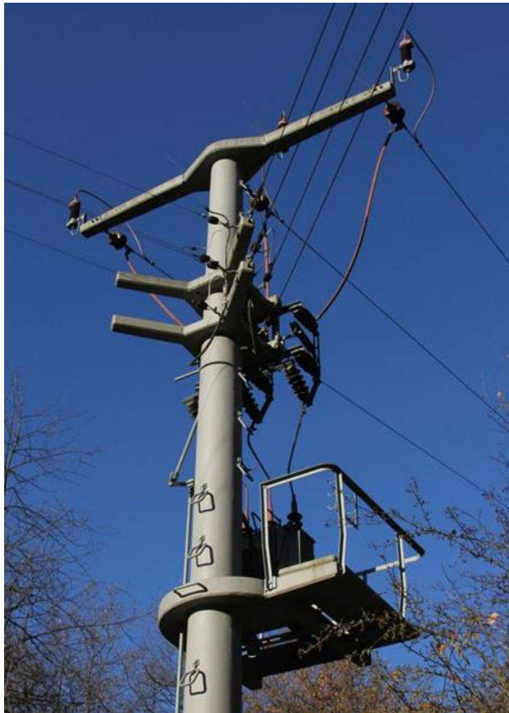
Foto 5: Nur teilweise gesicherter Mast im Steinbruch Vilmar (Foto: H.-O. Thorn)
