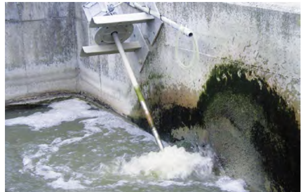
Abb. 10: Schnitt durch einen statischen Mischer in einer Rohrleitungsstrecke (links); Rührwerk zur Einmischung des Fällmittels (rechts) (Stadtwerke Schlitz)
