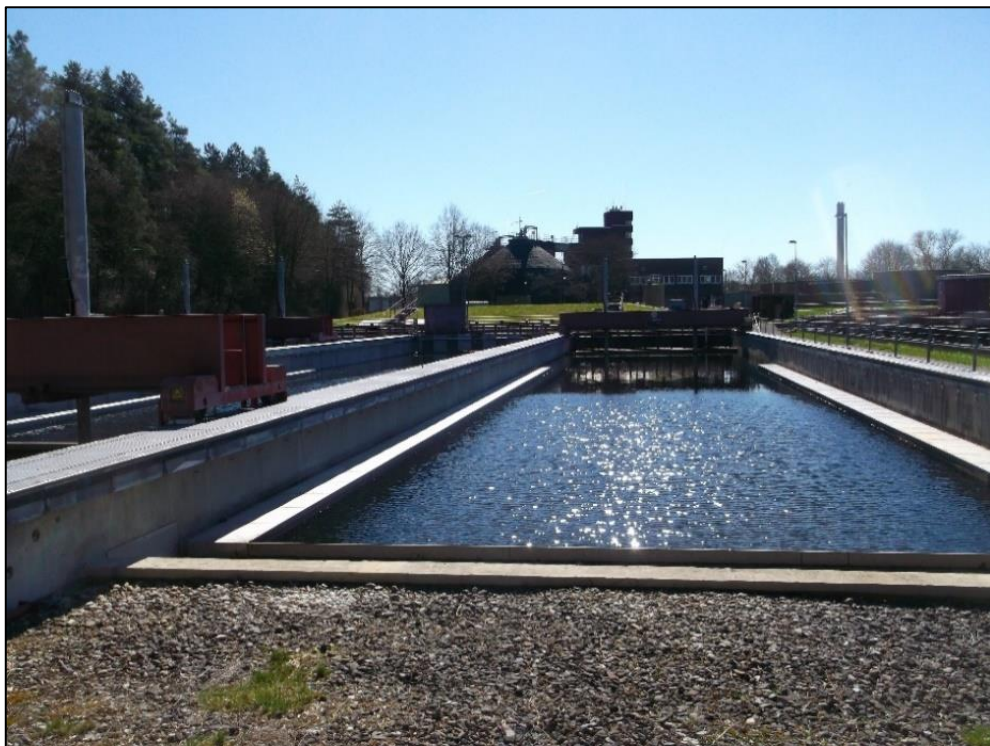
Abb. 19: Kläranlage Fulda / Gläserzell: Blick auf Nachklärbecken 3 mit Betriebsgebäude und Faultürmen im Hintergrund (Foto: Abwasserverband Fulda).
