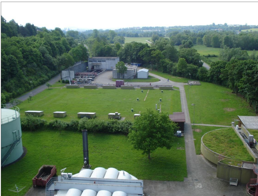
Abb. 4: Kläranlage Fulda / Gläserzell: Blick auf abgedeckte Becken (Vorklärung, Regenüberlaufbecken, vorgeschaltete Denitrifikation) sowie Einlaufgruppe (Foto: Abwasserverband Fulda).
