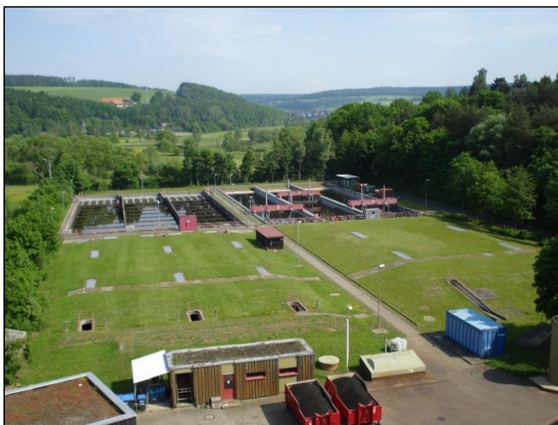
Abb. 1: Kläranlage Fulda / Gläserzell: Blick vom Faulturm auf die abgedeckten Belebungsbecken sowie die Nachklärbecken (Foto: Abwasserverband Fulda).
