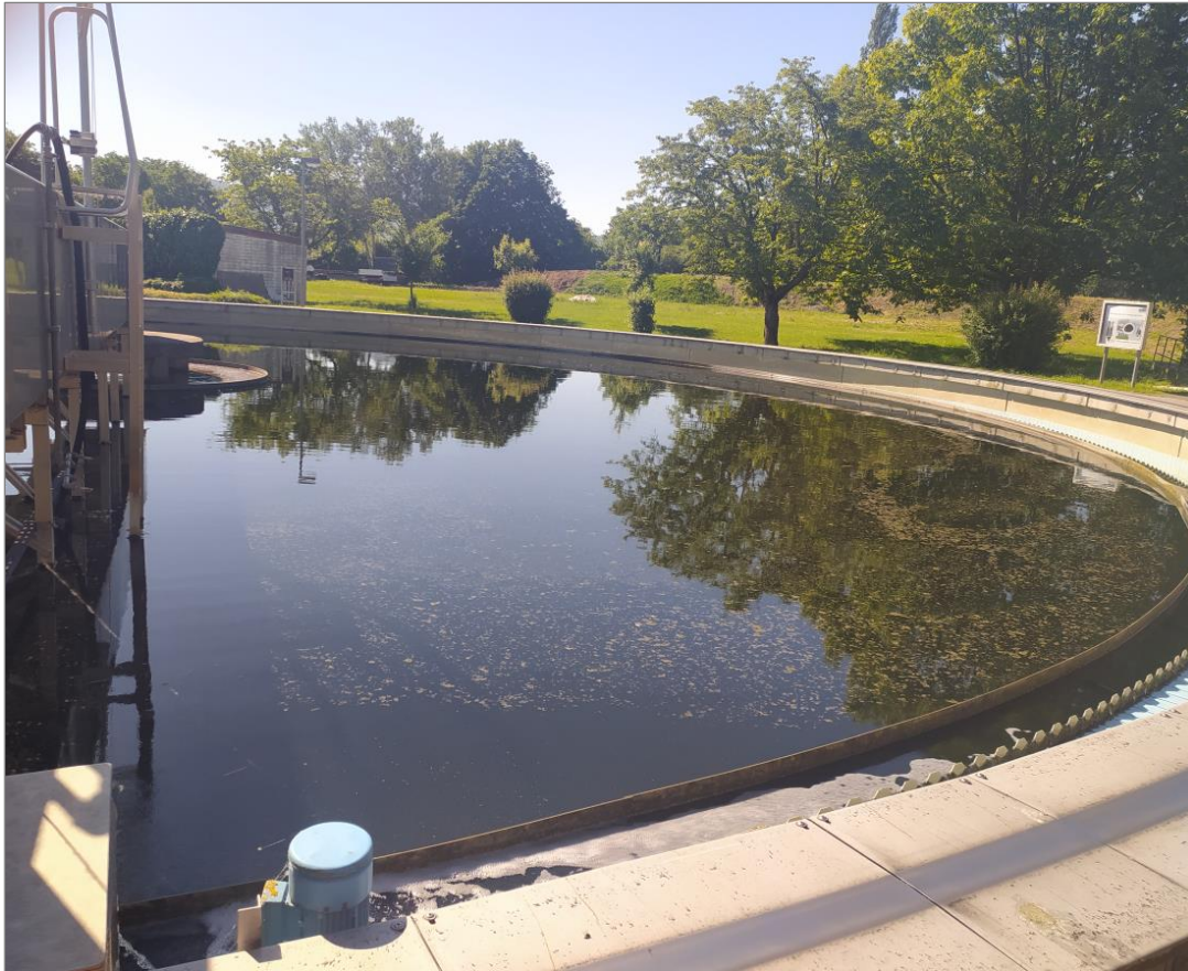
Abb. 1: Nachklärbecken der Kläranlage Bickenbach (Foto: HLNUG, Wiesbaden)
