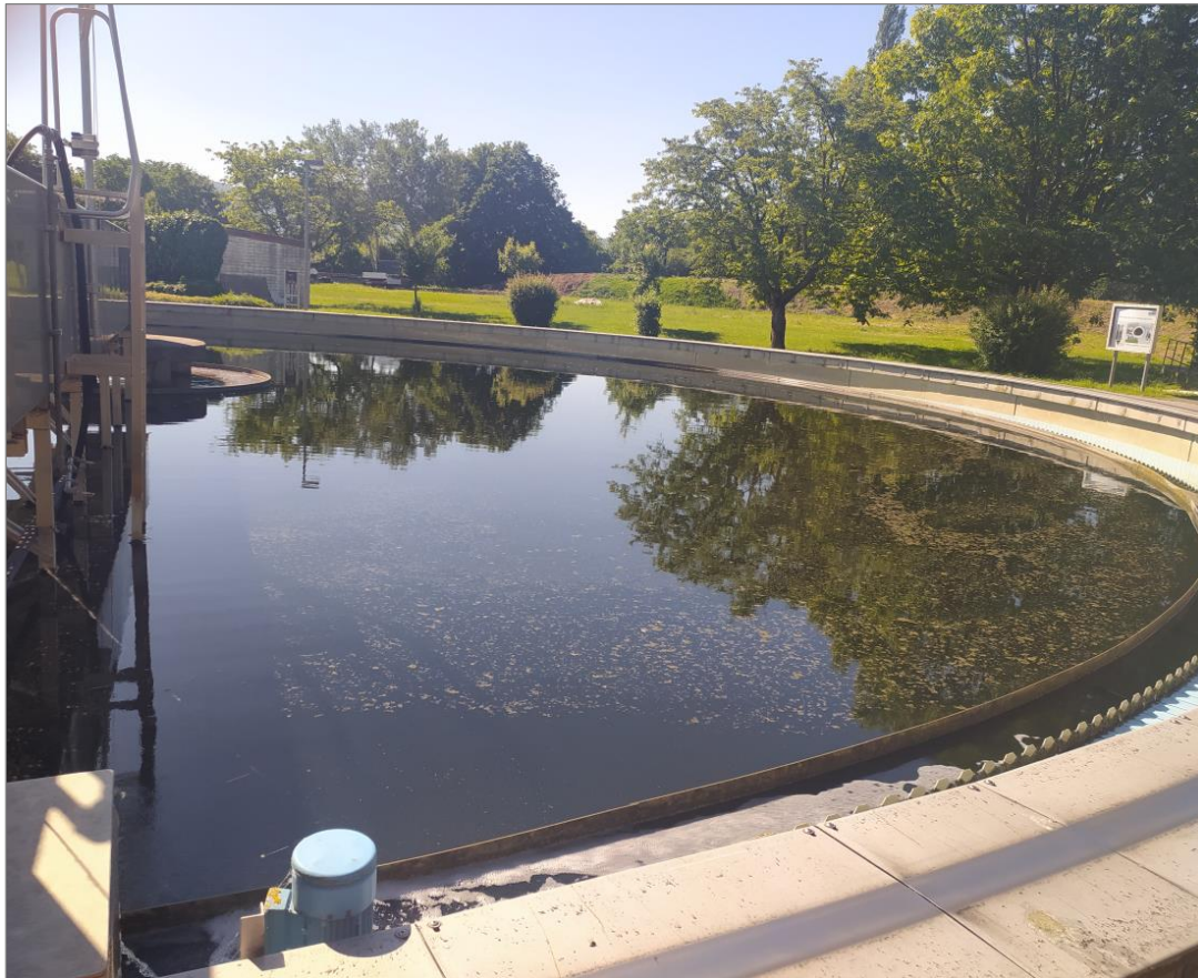
Abb. 1: Nachklärbecken der Kläranlage Bickenbach (Foto: HLNUG, Wiesbaden)
