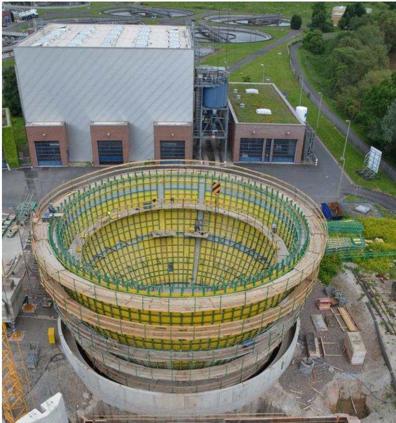
Abb. 1: Faulturm des Klärwerks Kassel im Bau (Foto: KASSELWASSER – Eigenbetrieb der Stadt).
