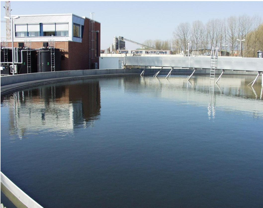
Abb. 4: Nachklärbecken mit Räumern des Klärwerks Kassel (Foto: KASSELWASSER – Eigenbetrieb der Stadt).
