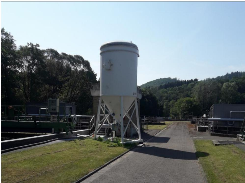
Abb. 18: Kläranlage Biedenkopf / Wallau: Blick auf Kreide-Dosierung in den Ablauf des am linken Bildrand gelegenen Vorklärbeckens (Foto: Abwasserverband Perfgebiet – Bad Laasphe).
