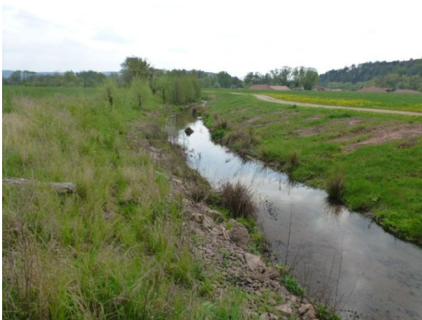
Foto 75: Solz_ab_5, Messst.ID 13899, renaturiert
