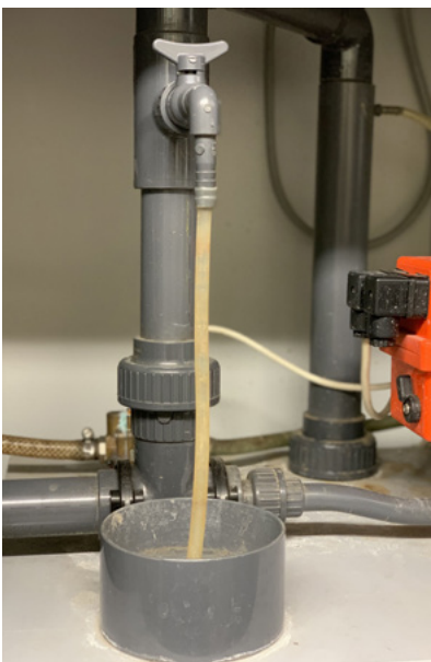
Abb. 9: Probenahmehahn, automatischer Probenehmer, Messsonden (v. l. n. r.) © HLNUG
