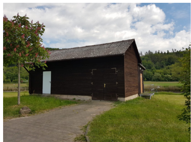
Abb. 17: Gewässergüte-MessstationWitzenhausen, Werra © HLNUG
