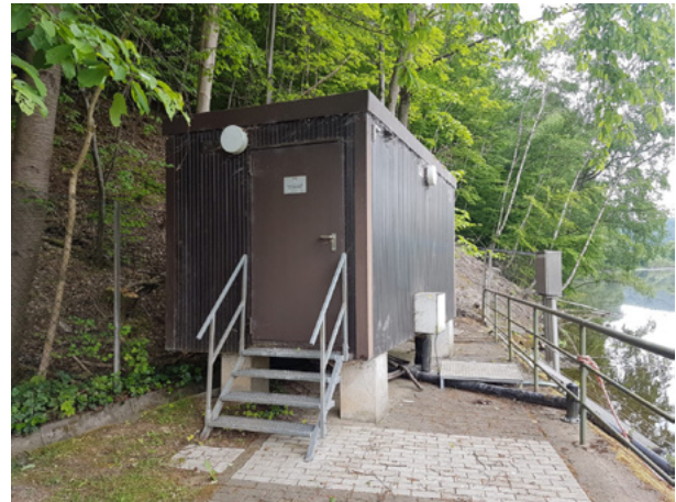
Abb. 16: Gewässergüte-Messstation Wahnhausen, Fulda © HLNUG
