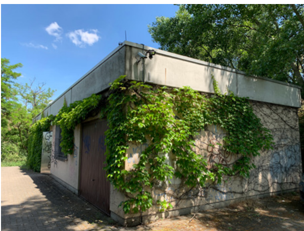
Abb. 11: Außenansicht Gewässergüte-Messstation Bischofsheim, Main © HLNUG
