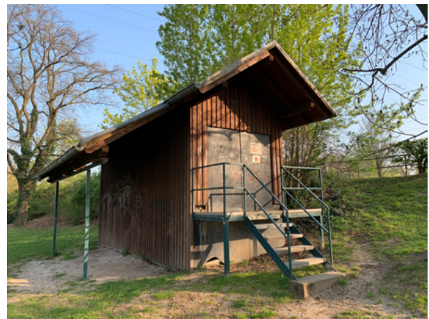
Abb. 12: Außenansicht Gewässergüte-Messstation Nied, Nidda und Main © HLNUG
