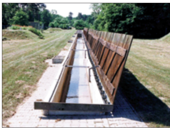
Sickerschlitzgraben und Einzelbohrungen zur Infiltration
