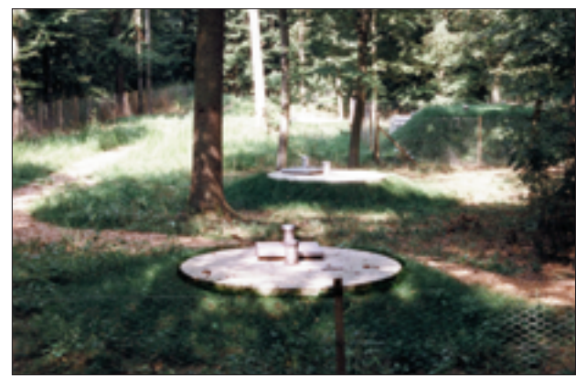
Sickerschlitzgraben und Einzelbohrungen zur Infiltration
