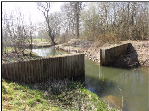
Abbildung 3.11: Drosselbauwerk des Retentionsraums Groß-Zimmern bei Mittelwasser, Quelle: BGS Wasser
