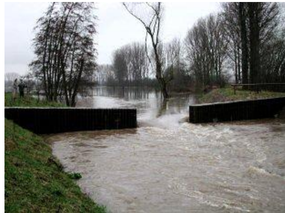
Abbildung 3.12: Drosselbauwerk des Retentionsraums Groß-Zimmern bei Hochwasser, Quelle: Wasserverband Gersprenzgebiet
