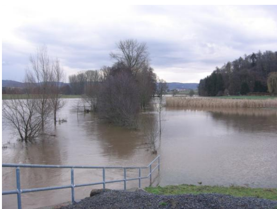
Abbildung 3.4: Hochwasser vom Januar 2011, Einstau Rückhalteraum Wersau/Groß-Bieberau, Quelle: BGS Wasser
