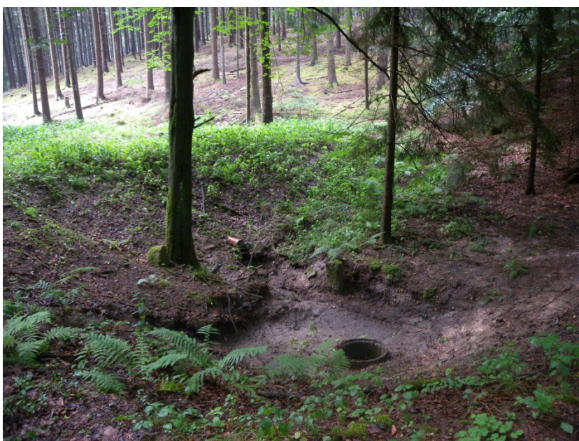
Abbildung 7.1: Beispiel einer Geländemulde mit Verwallung und Grundablass am Hollerbrunnenweg (Zufluss zum Erdbach)
