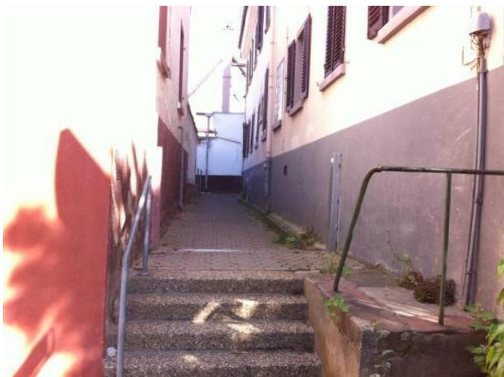
Abb. 3.8: Führungsschienen für mobiles Hochwasserschutzsystem mit Dammbalken, im Alten Kirschgarten (Bildfreigabe durch icon)
