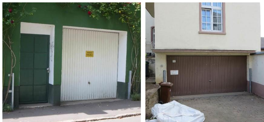
Abb. 2.19: Vorbereitete U-Schienen zum Einsetzen von Dammbalken (Bildfreigabe durch Hässler-Kiefhaber)
