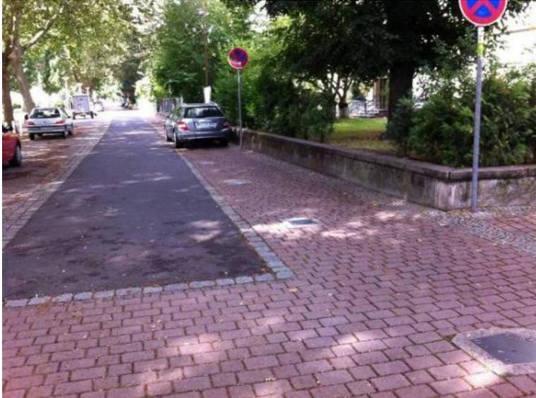
Abb. 3.12: Bodenankerplatten für mobiles Hochwasserschutzwand-System mit Dammbalken, Schierstein (Bildfreigabe durch icon)
