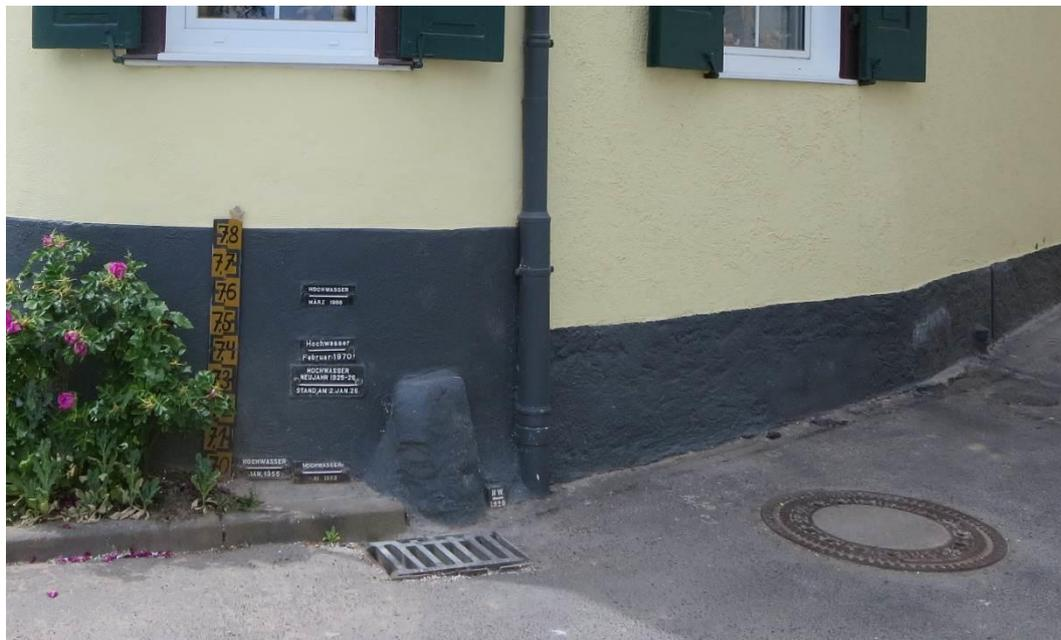
Abb. 2.18: *Hochwasser steht über der Straßenoberkante und verursacht auch Probleme durch rückstauendes Abwasser (Bildfreigabe durch Hässler-Kiefhaber)*
