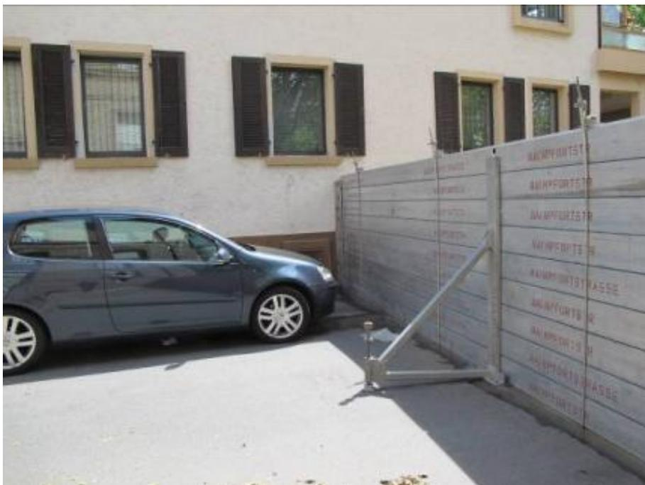
Abb. 2.13: Mainz-Kostheim Mainpfortstraße, Aufgebautes mobiles Hochwasserschutzsystem mit Dammbalken beim Hochwasser Juni 2013 (Bildfreigabe durch UWB Wiesbaden)
