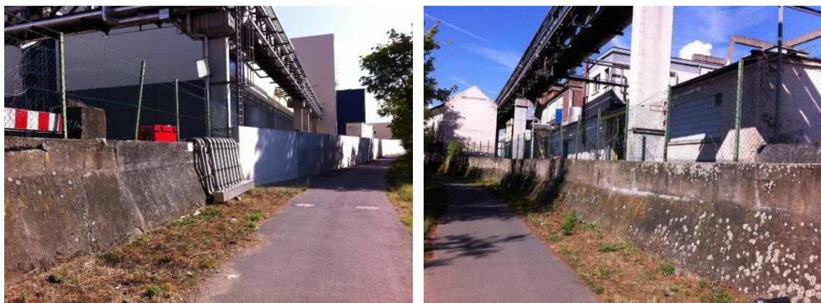
Abb. 3.16: Hochwasserschutzwand SCA HYGIENE PRODUCTS GmbH (Bildfreigabe durch icon)
