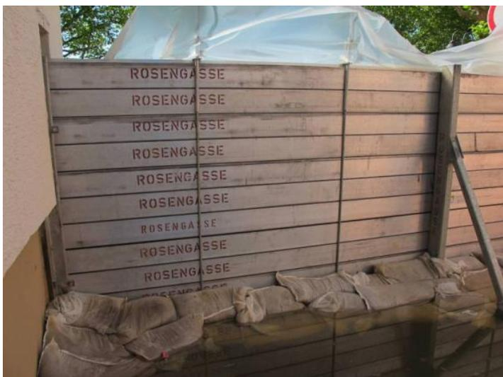
Abb. 3.7: Mobile Hochwasserwand in der Rosengasse (Bildfreigabe durch UWB Wiesbaden)
