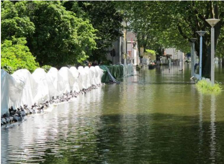
Abb. 3.13: Mobile Hochwasserschutzwand aus Dammbalken beim Hochwasser im Juni 2013 - Wiesbaden Schierstein (Bildfreigabe durch UWB Wiesbaden)
