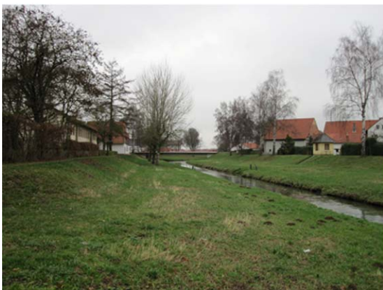
HW-Schutzdeich in Röllshausen an der Schwalm
