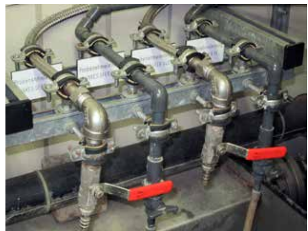
Abb. 41: Probenahmeleitungen zur manuellen Entnahme von Stichproben am rechten und linken Ufer des Mains in Bischofsheim.
