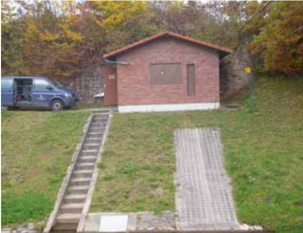
Abb. 13+14: Pegel Steinau, Außen- und Innenansicht.
