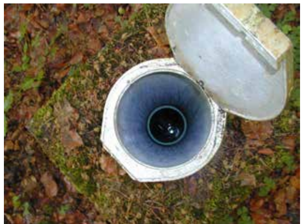
Abb. 62: Blick in eine Grundwassermessstelle in Mellnau, Burgwald.
