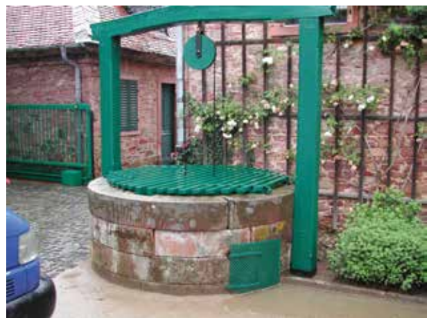
Abb. 63: Grundwassermessstelle in Langen, Untermainebene (ungenutzter ehemaliger Flachbrunnen.).
