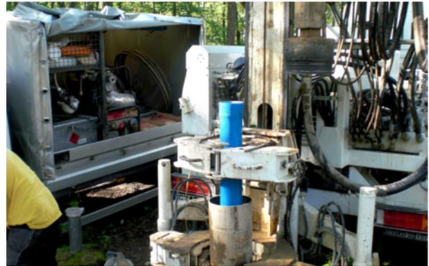
**Abb. 65:** Eingebautes Brunnenrohr bei einer Grundwassermessstelle.
