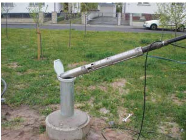
**Abb. 60:** Einbau einer Unterwassermotorpumpe in eine Grundwassermessstelle.
