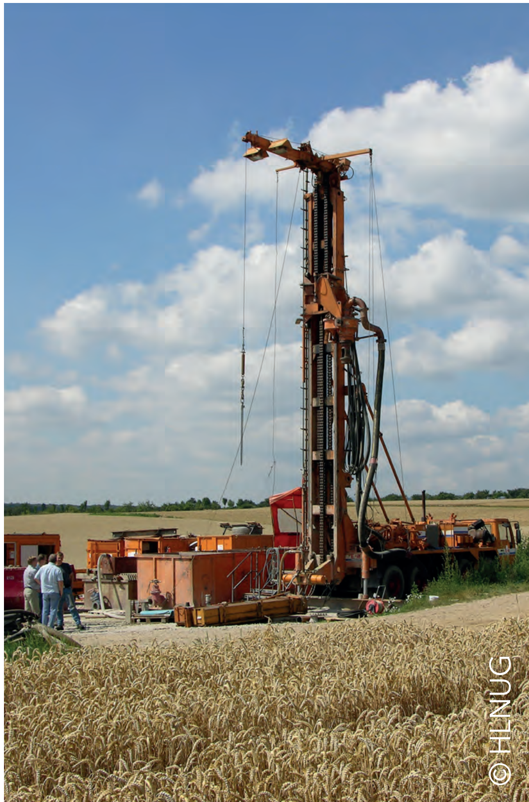
Bohrung zur Grundwassererschließung
