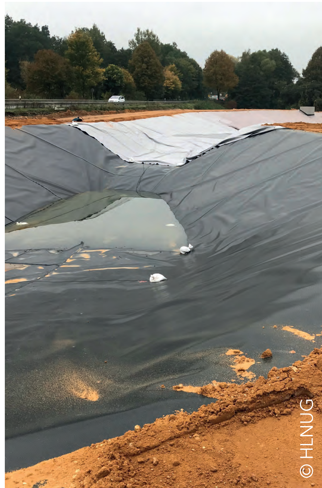
Regenrückhaltebecken im Wasserschutzgebiet
