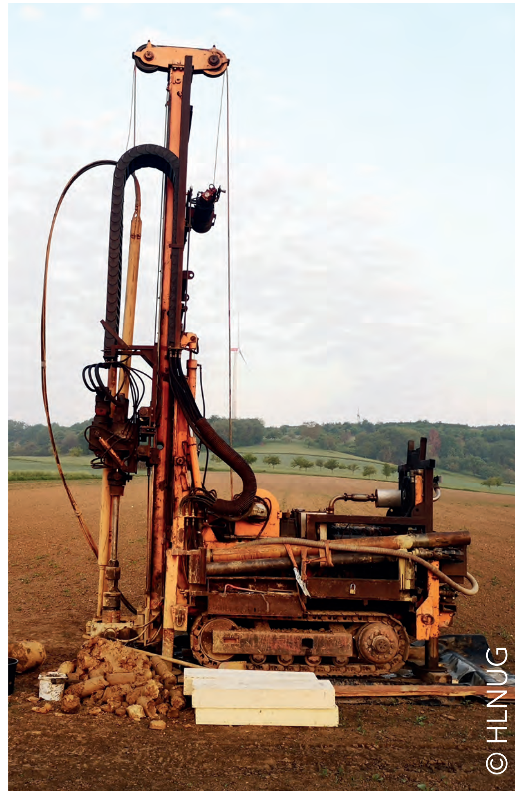
Baugrunderkundung mittels Rammkernsondierung
