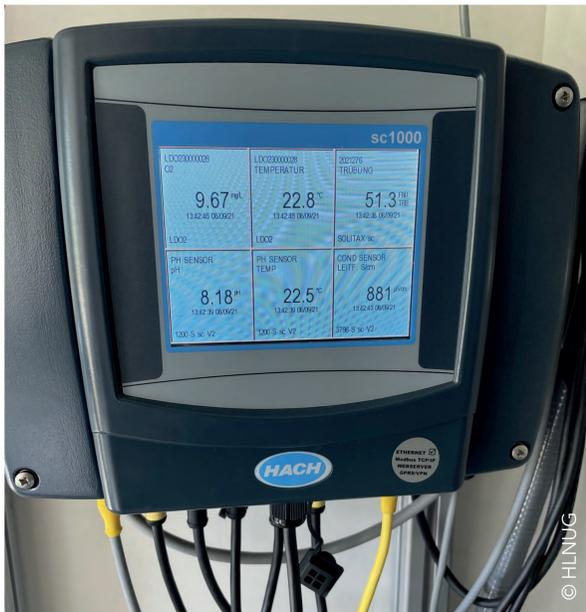
Abb. 1: Multiparameter Universalcontroller
