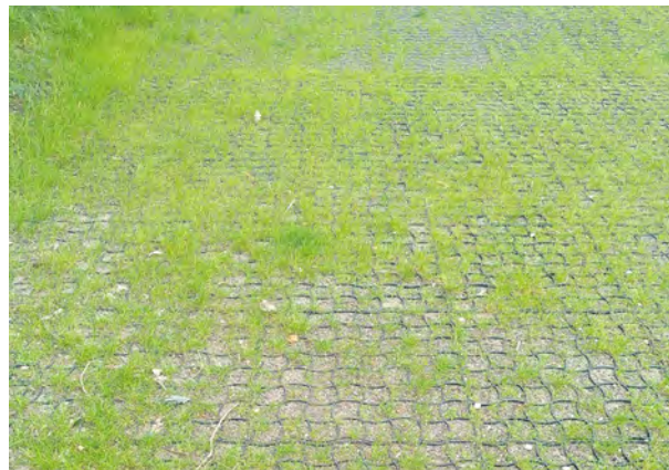
Abb. 9: Statt Parkplätze zu asphaltieren oder zu pflastern, können sie auch mit Hilfe wasserdurchlässiger Gittersysteme befestigt werden © HLNUG
