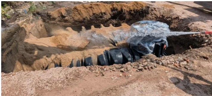
Abbildung 48: Einsatz einer unterirdischen Zisterne (Foto: e-netz Süd Hessen AG).
