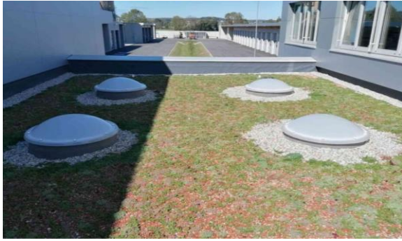
Abbildung 34: Extensive Dachbegrünung mit Sedumsprossen (Foto: © GRÜNSTATTGRAU).
