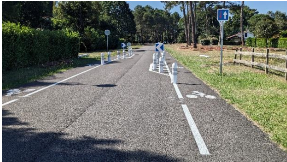
Abbildung 20: Beispiel Radweggestaltung (Foto: e-netz Süd Hessen AG).
