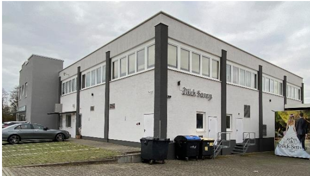
Abbildung 28: Helle Fassadenfarbe als Best-Practice-Beispiel "Odenwaldstraße 2, Groß-Gerau" (Foto: Effizienz:Klasse GmbH).
