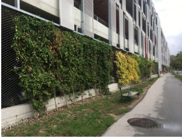
Abbildung 25: Bodengebundene Begrünung an einem Parkhaus (Foto: © GRÜNSTATTGRAU, Weiss-Tessbach).
