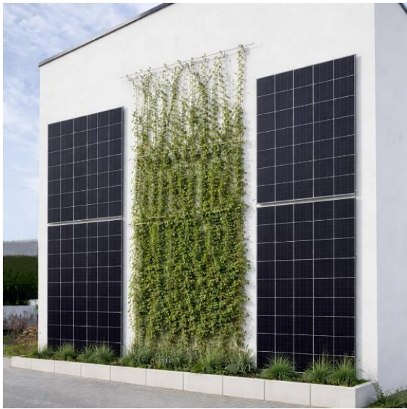
Abbildung 23: Bodengebundene Begrünung mit PV-Anlage (Foto: KI generiert).
