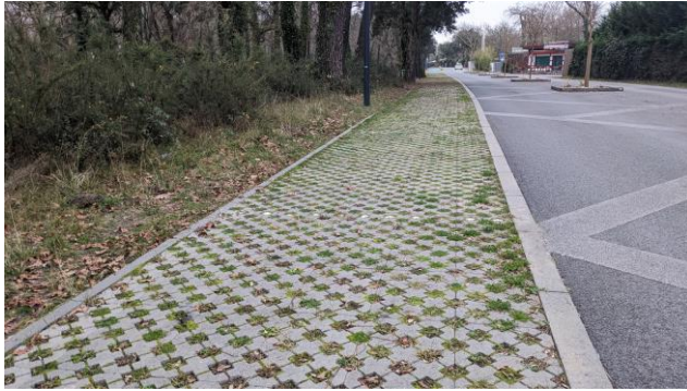
Abbildung 42: Stellplätze mit Rasengittersteinen (Foto: e-netz Süd Hessen AG).
