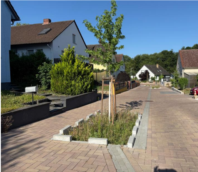
Abbildung 39: " Tiefbeet/Baumrigole“ mit oberflächiger Zuführung des Niederschlagswassers in Reinheim-Ueberau; (Foto: IB Reitzel).
