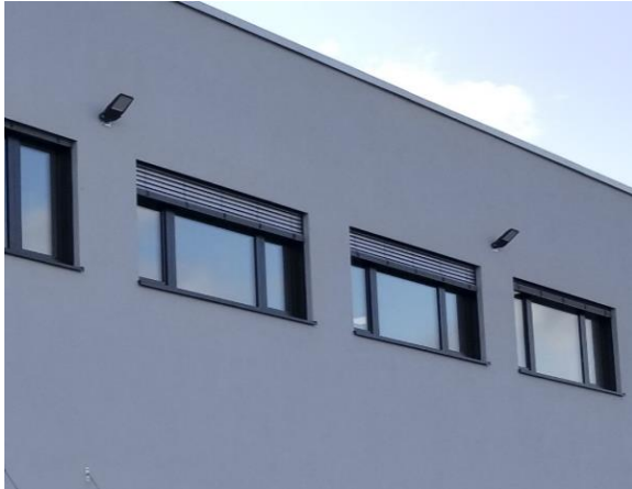
Abbildung 37: Außenliegende Verschattung an saniertem Nichtwohngebäude (Foto: Effizienz:Klasse GmbH).
