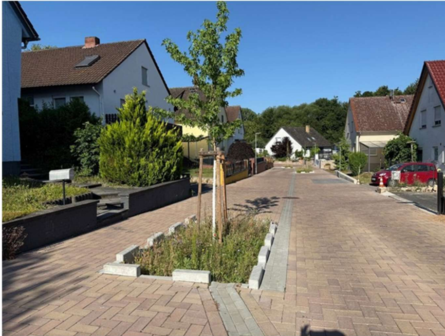
Abbildung 47: „Tiefbeet/Baumrigole“ mit oberflächiger Zuführung des Niederschlagswassers in Reinheim-Ueberau; (Foto: IBR)
