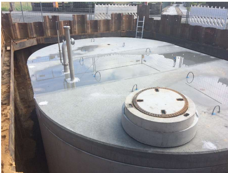
Abbildung 46: Einbau einer unterirdischen Zisterne in Mainhausen (Foto: IBR)
