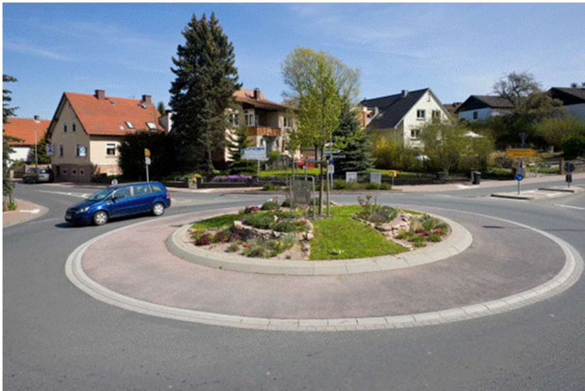
Abbildung 42: Kreisverkehr in der Gemeinde Brensbach (Foto: IBR)
