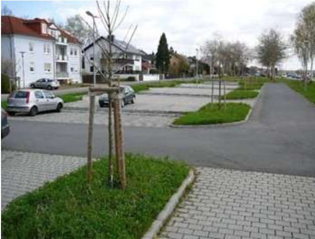
Abbildung 44: Stellplätze mit versickerungsfähigem Pflaster und Bauminseln im Freibad Dieburg (Foto: IB Reitzel)
