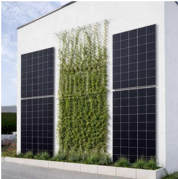
Abbildung 16: Bodengebundene Begrünung mit PV-Anlage (Foto: KI generiert)
