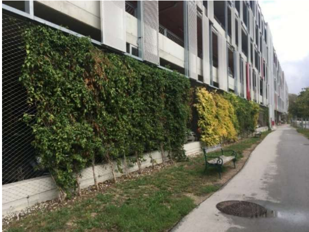
Abbildung 18: Bodengebundene Begrünung an einem Parkhaus (Foto: © GRÜNSTATTGRAU, Weiss-Tessbach)
