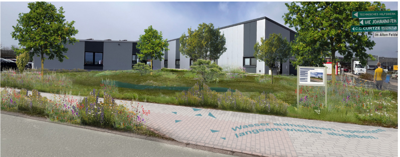
Abb. 61: Infotafel und Bodenmarkierungen am neuen Retentionsbecken
