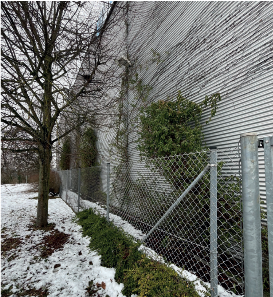
Abb. 31: Begründe Südfassade der Firma Sanden (Aufnahme: UmbauStadt PartGmbH, Feb. 2026)
