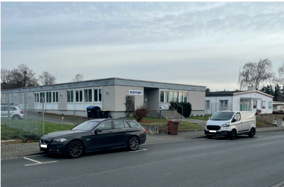
Abb. 6: Bestandgebäude „Am Taubenbaum 6“ (Aufnahme: UmbauStadt PartGmbH, Nov. 2025)
