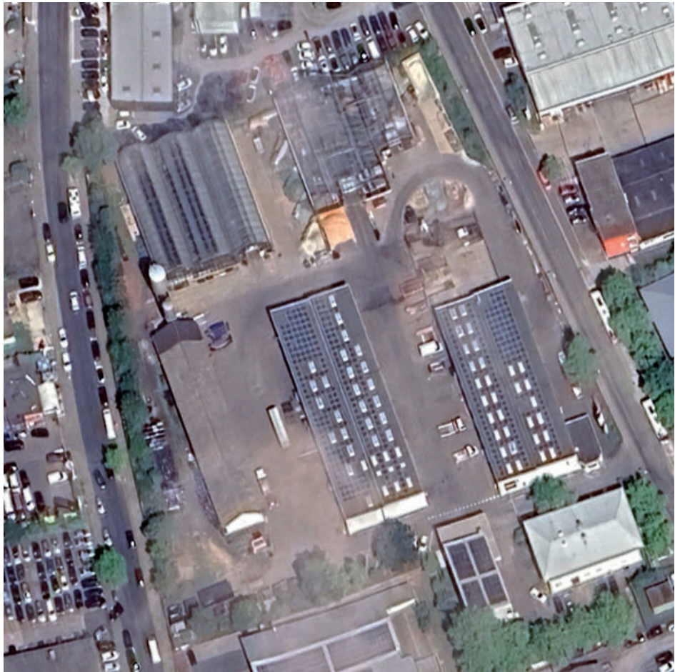
Abb. 52: Bestandssituation Fokusraum Stadtwerke Bad Nauheim (Luftbild Google Earth)
