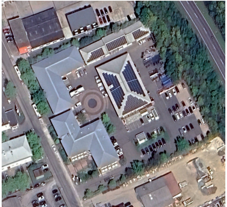
Abb. 49: Bestandssituation Fokusraum Stadtwerke Bad Nauheim (Luftbild Google Earth)
