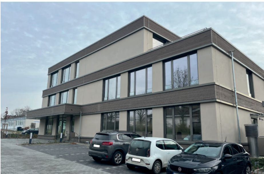
Abb. 8: Flachdach der Wohnungsbaugesellschaft mbH in der Straße „Am Taubenbaum 13“ (Aufnahme: UmbauStadt PartGmbH, Nov. 2025)
