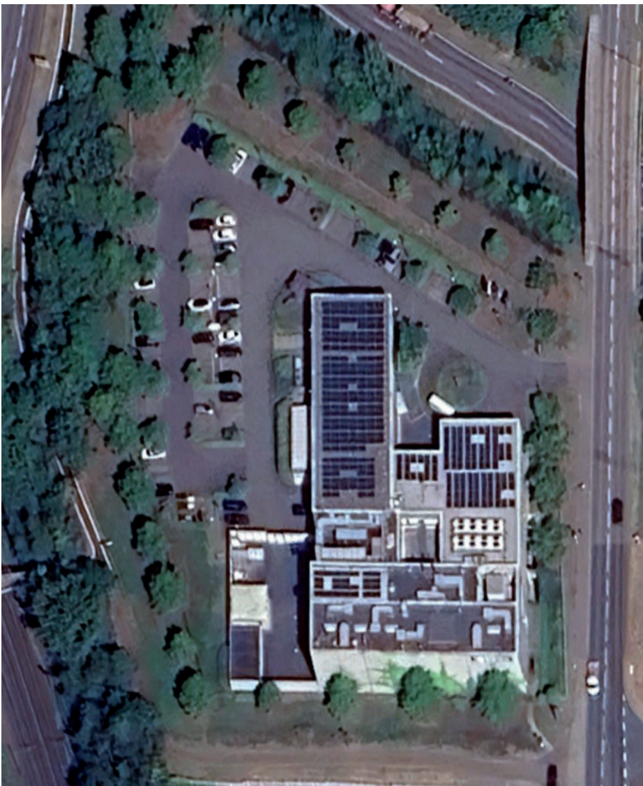
Abb. 55: Bestandssituation Fokusraum Firma Sanden International (Europe) GmbH (Luftbild Google Earth)
