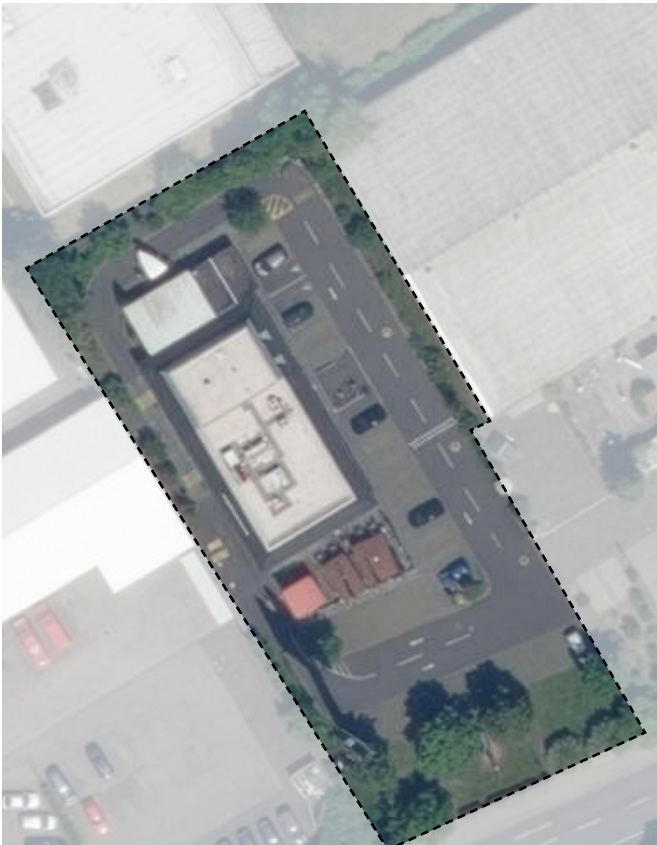
24 Luftbild des Standortes (Ausschnitt vom DOP20 der Kreisfreien Stadt Offenbach am Main, 2025)
