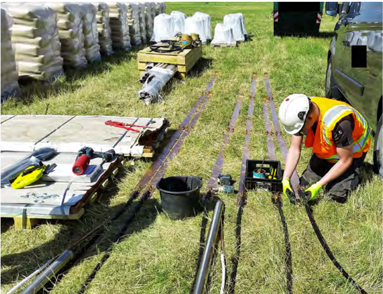
Abb. 4: Vorbereitung der Kupferelektroden für ERH (Kap. 6.3) © Regierungspräsidium Darmstadt
