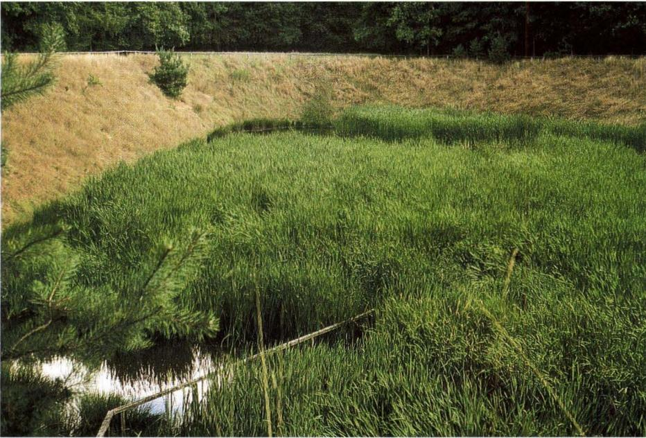
**Abb. 1.** Versickerbecken der A 3 mit nördlichem Beckenrand am 12. 8. 1997. Beckensohle zu etwa 80 % mit Rohrkolben bewachsen.
