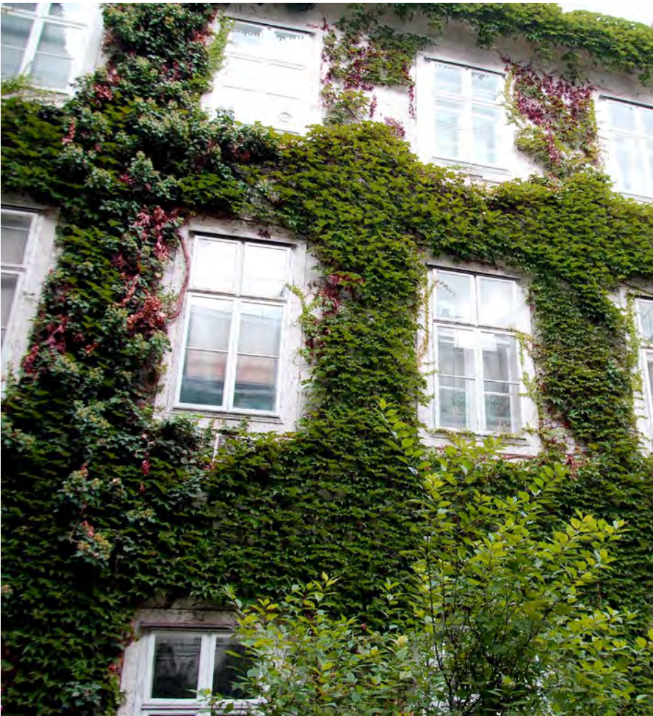
Abb. 2: Bodengebundene Fassadenbegrünung im Innenhof © Gruchmann/GRÜNSTATTGRAU
