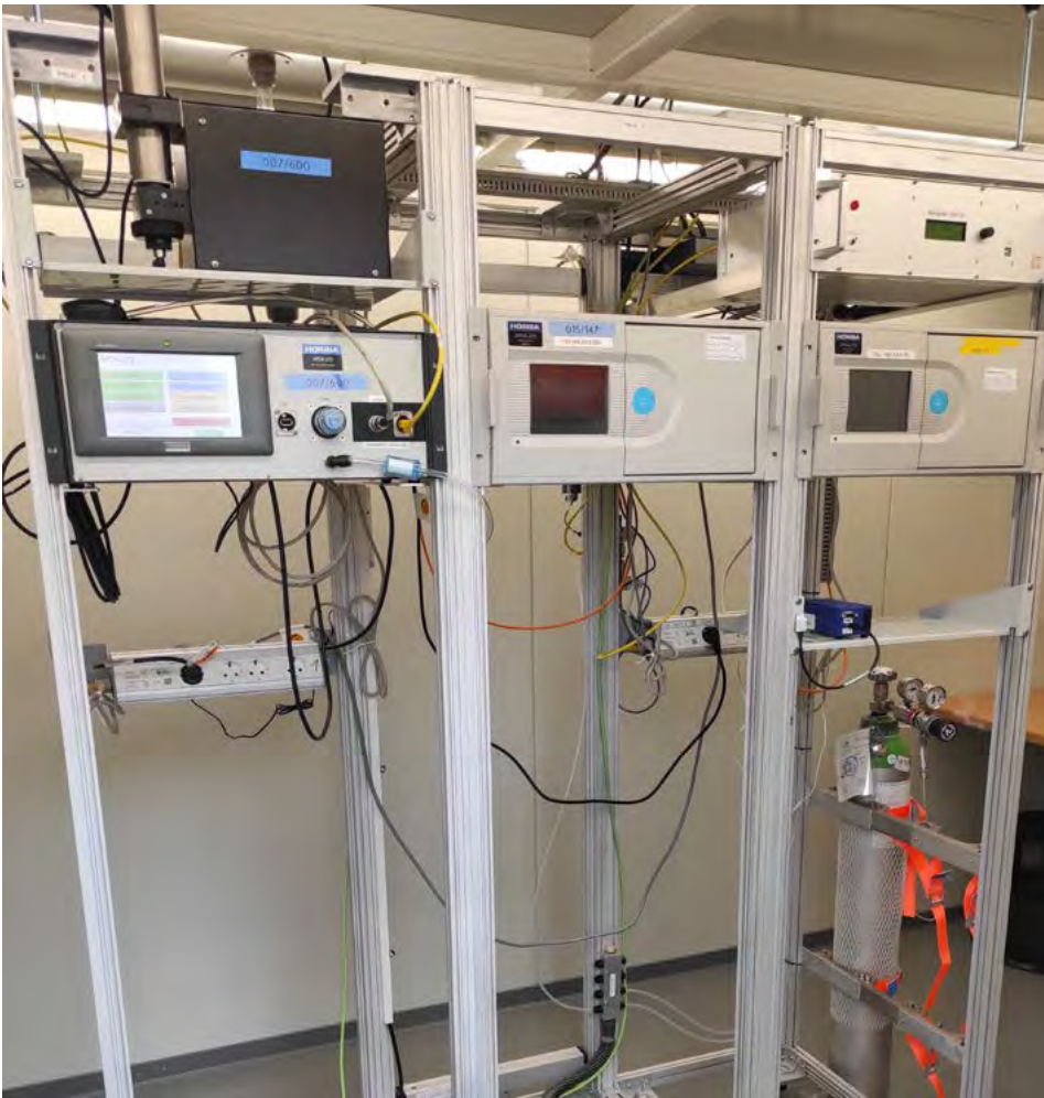
Abb. 4: Einbau der Messgeräte im neuen Container (Luftmesstation Bebra) © HLNUG
