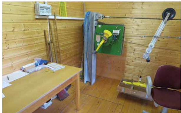
Abb. 16: Pegel Essershausen an der Weil, Innenansicht des Pegelhauses mit Seilkrananlage, Arbeitsplatz und Einrichtung zur Datenfernübertragung
