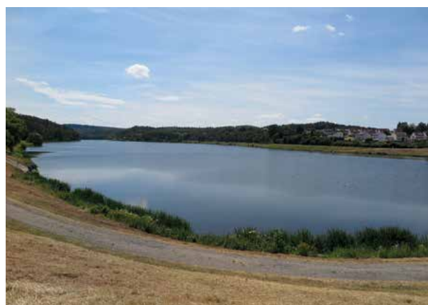
Abb. 25: Twistetalsperre im Juli 2019
