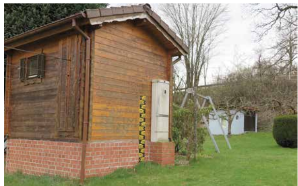
Abb. 17: Pegel Essershausen an der Weil im März 2019, Außenansicht des Pegelhauses mit Pegellatte
