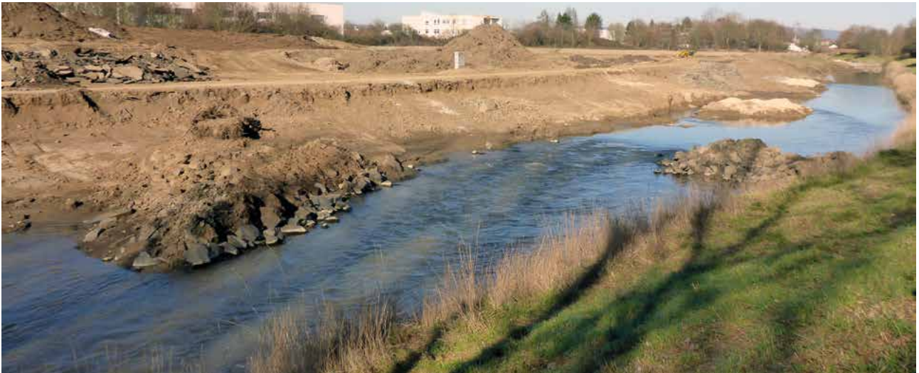
Abb. 61: Laufende Renaturierungsmaßnahmen an der Nidda bei Karben
