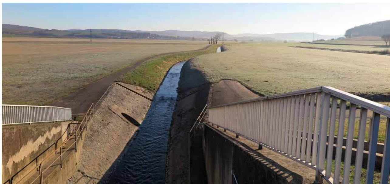
Abb. 32: Hochwasserrückhaltebecken (HRB) Düdelsheim im Februar 2019
