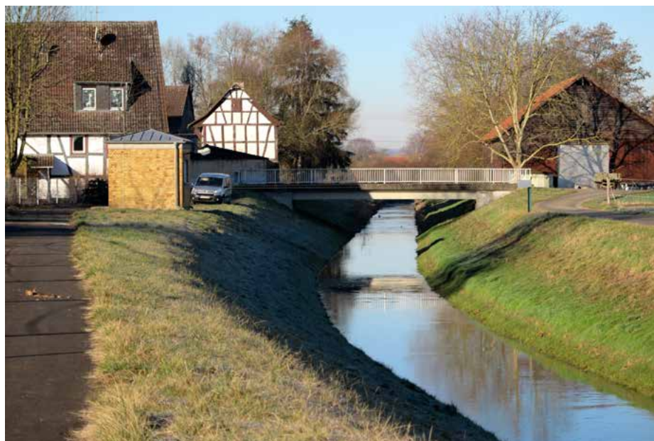
Abb. 21: Pegel Düdelsheim am Seemenbach im Februar 2019
