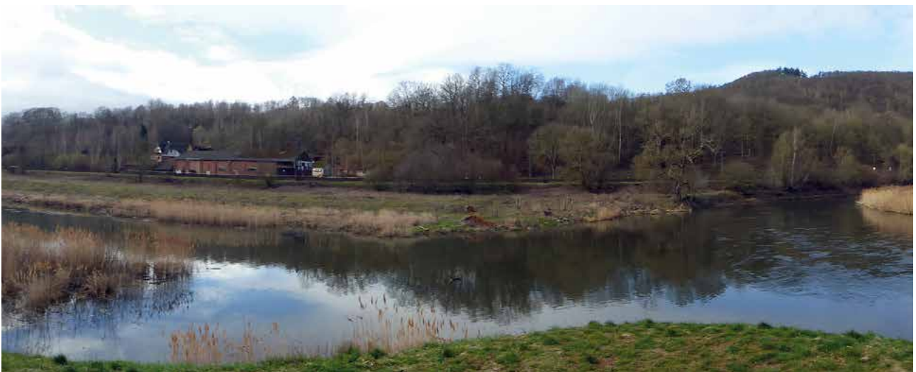
Abb. 67: Einlauf der Flutmulde am „Nordkapp“ bei Albungen in die Werra (rechts)
