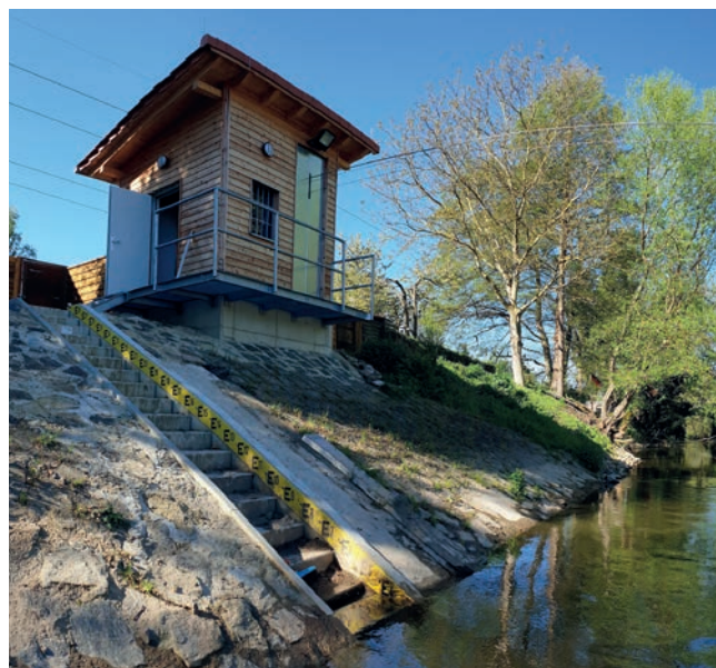
Abb. 17: Neu saniertes Pegel Harreshausen an der Gersprenz, Ende August 2020 © RP Darmstadt (Jutta Bernhardt)
